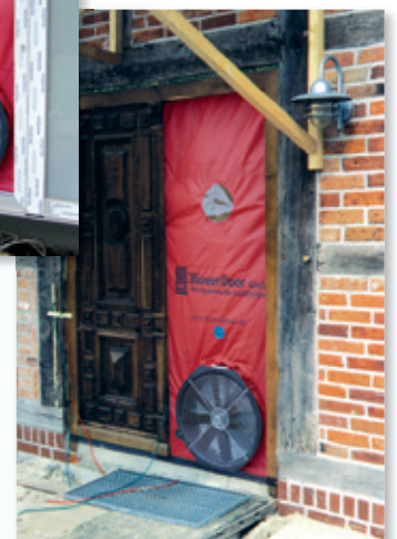
Pomiar BlowerDoor podczas remontu domu z muru pruskiego
