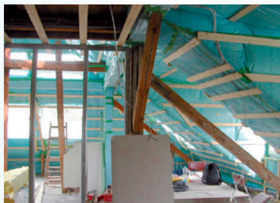
Bariera powietrzna jest jeszcze widoczna (folia i panele drewniane): Jest to najlepszy czas do przeprowadzenia pomiaru BlowerDoor.
