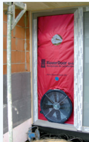
Test BlowerDoor w nowo wybudowanym domu jednorodzinnym
